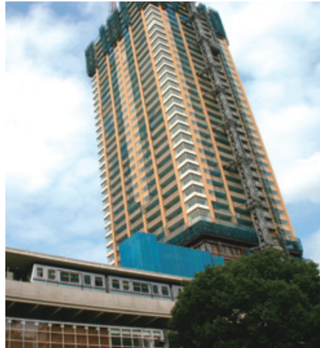
日暮里・舎人ライナー開業を契機に、大規模な駅改良と駅前再開発が行われている日暮里駅
